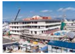
建設中の倉敷平成病院 昭和62年
