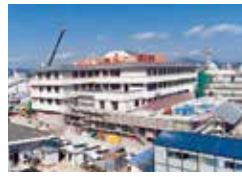
建設中の倉敷平成病院 1987 (S62)年
